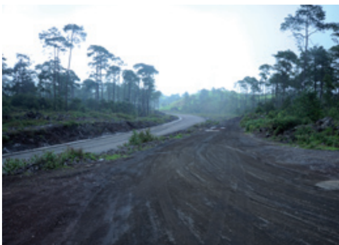
Abb. 4: Neubau einer Schnell- straße im Habitat von Chiropterotriton lavae . Foto: NERZ
