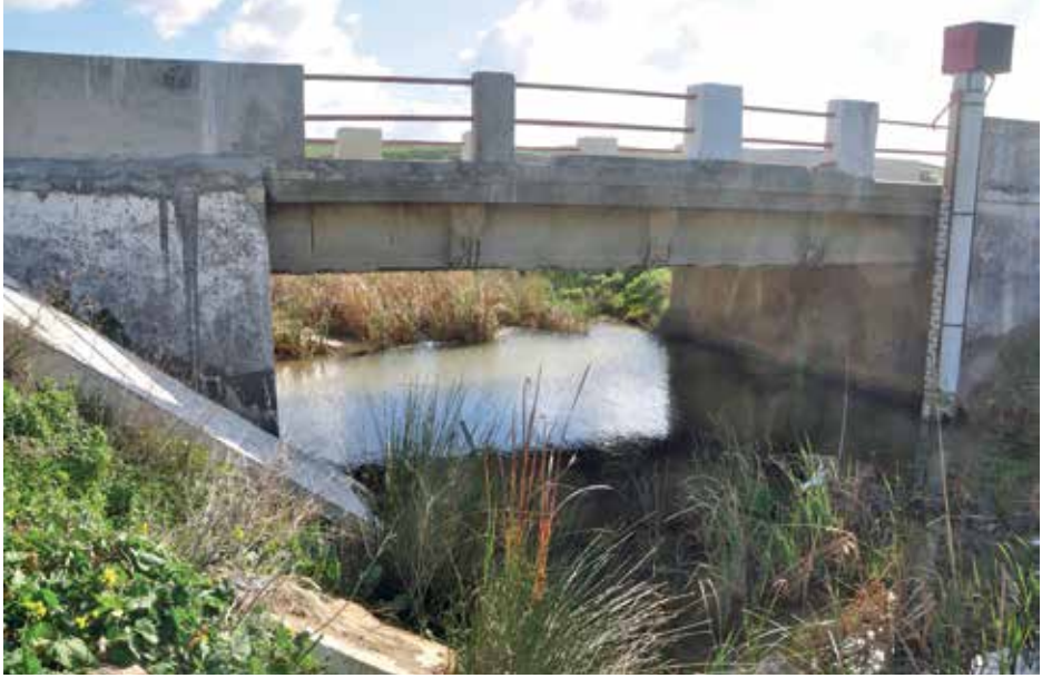
Abb. 2: Melorationsgraben in der Ebene des Ichkeul See, 06.01.2020. Foto: S. VOITEL
